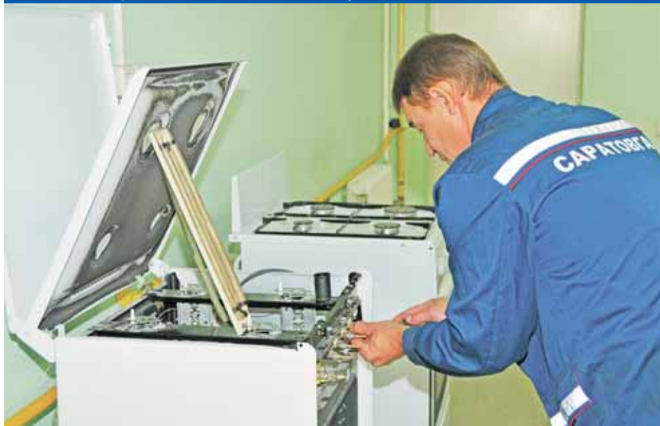
Конкурс профессионального мастерства на звание «Лучший по профессии» ОАО «Саратовгаз». Техническое обслуживание бытовой газовой плиты.
