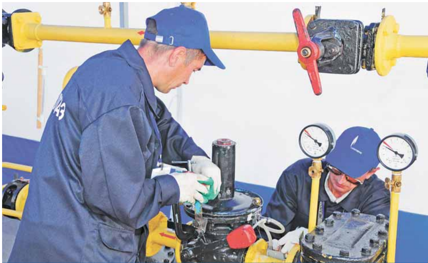
Конкурс профессионального мастерства на звание «Лучший по профессии» ОАО «Саратовгаз». Настройка предохранительно-сбросного и предохранительно-запорного клапанов (ПСК и ПЗК) в газорегуляторном пункте (ГРП) на безопасный параметр срабатывания (максимальный и минимальный) от заданного рабочего давления.
